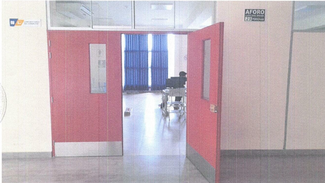
Figura N° 05. Puerta principal del laboratorio de Cómputo.
