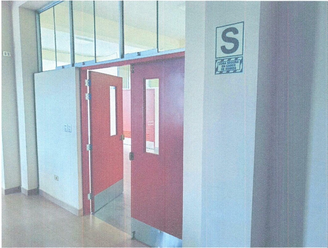
Fotografía 03: Señalizaciones en el Centro de Cómputo.
