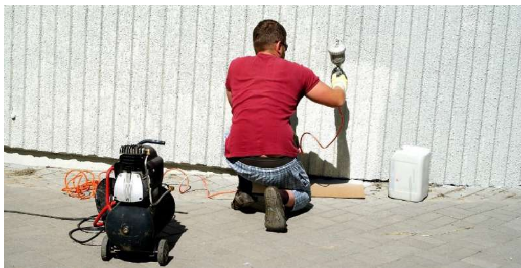
Figura 3. Aplicación de pintura sobre superficie.
