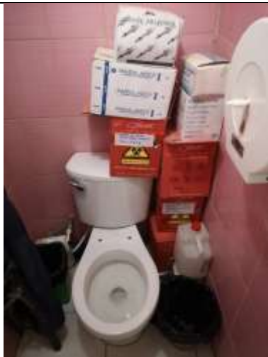
Foto 11: Diagnóstico In Situ – Unidad de Servicios de Salud, almacenamiento inadecuado de cajas con residuos punzocortantes
